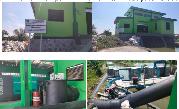
Gambar 2. Rumah Pompa Milik Pemerintah Kabupaten Sidoarjo
